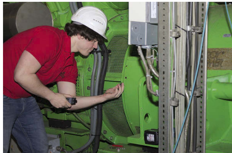
Die Montage des Sensors am Kraftwerksgenerator
